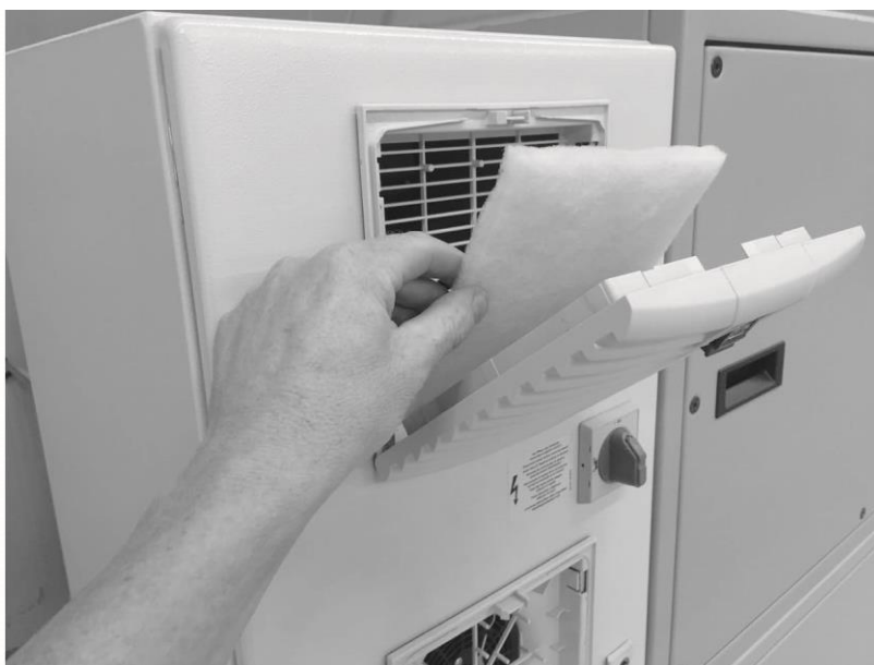
Obr. 57: Výměna filtrů skříňového rozvaděče
