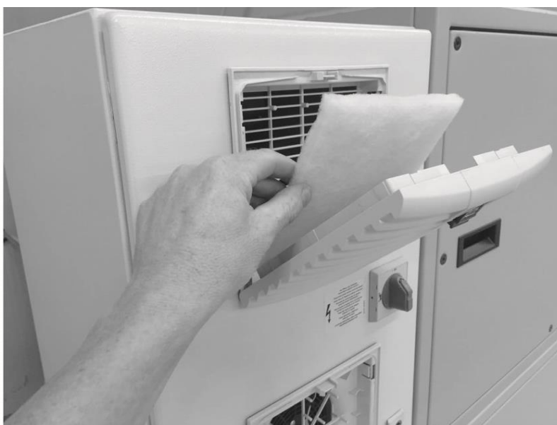
Рис. 205: Замена фильтра распределительного шкафа
