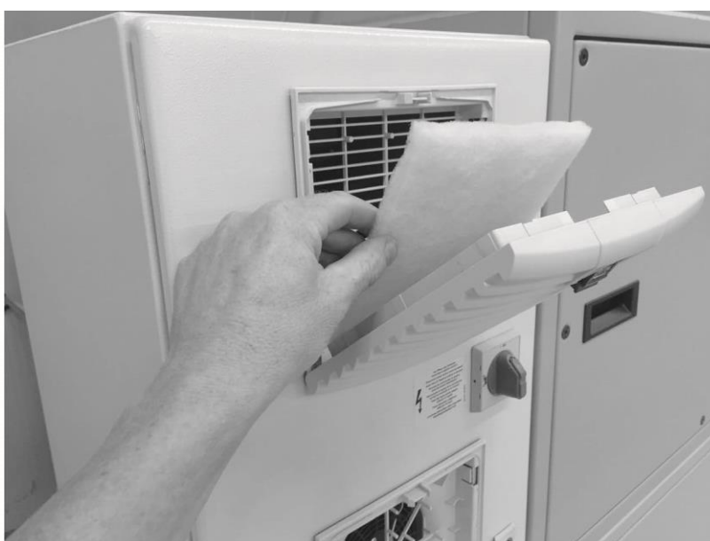
Rys. 131: Wymiana filtra szafy sterowniczej
