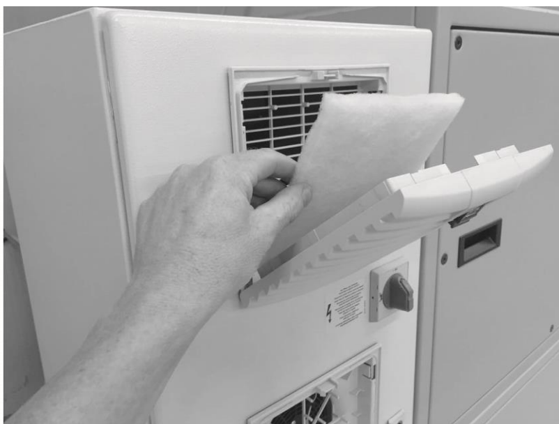
Fig. 57 : remplacement du filtre armoire de commande
