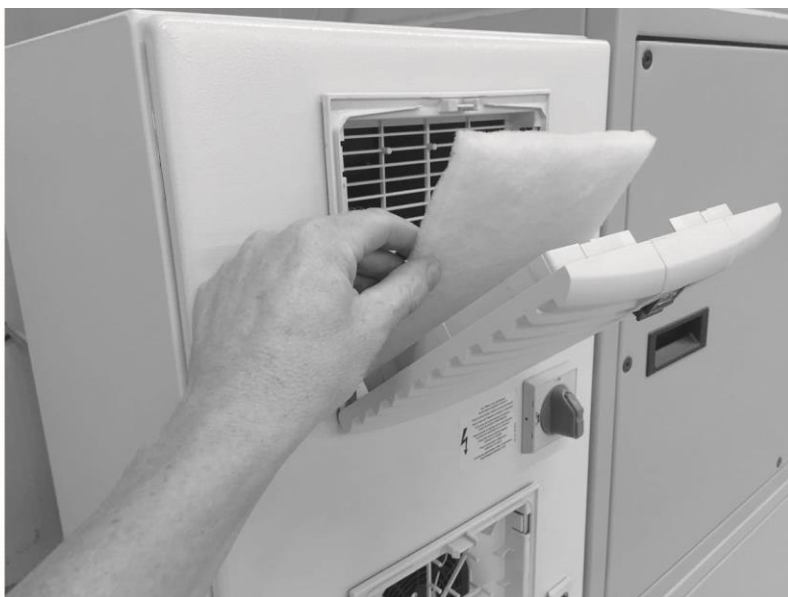
Fig. 353: Sostituzione filtro e quadro elettrico
