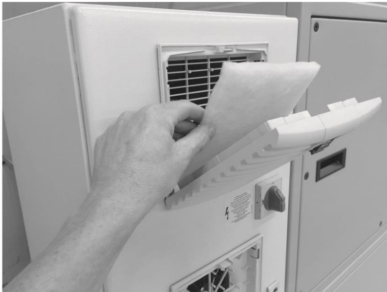
Fig. 205: Cambio del filtro del armario de distribución
