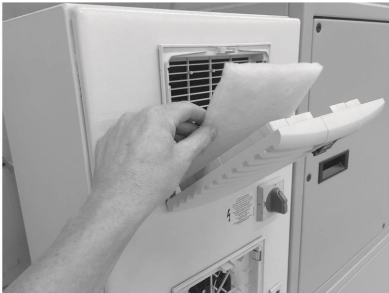
Fig. 279: Substituição do filtro no armário de distribuição
