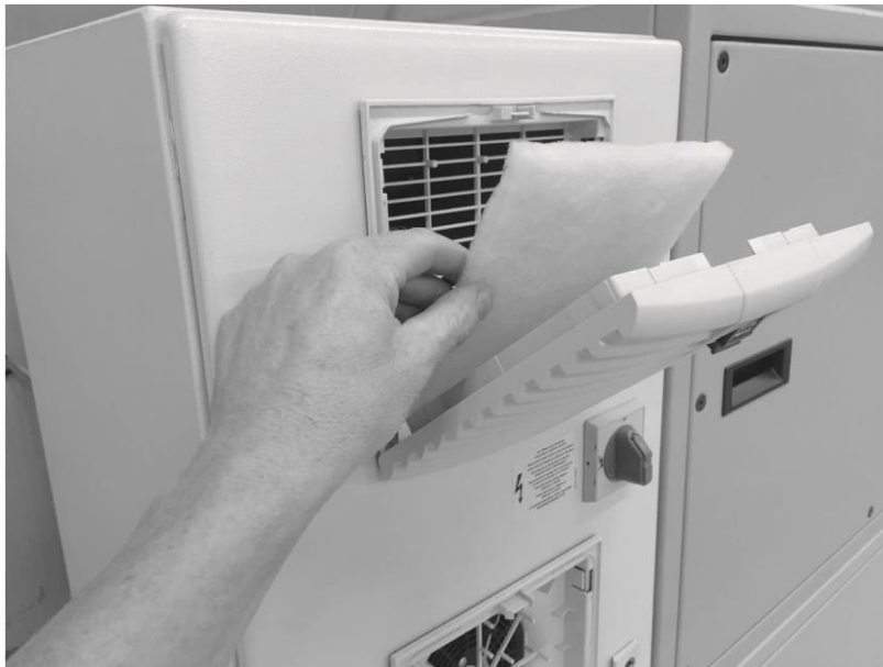
Obr. 39: Výměna filtrů skříňového rozvaděče
