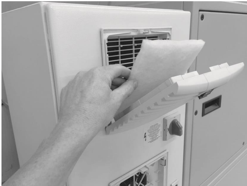
Rys. 96: Wymiana filtra szafy sterowniczej
