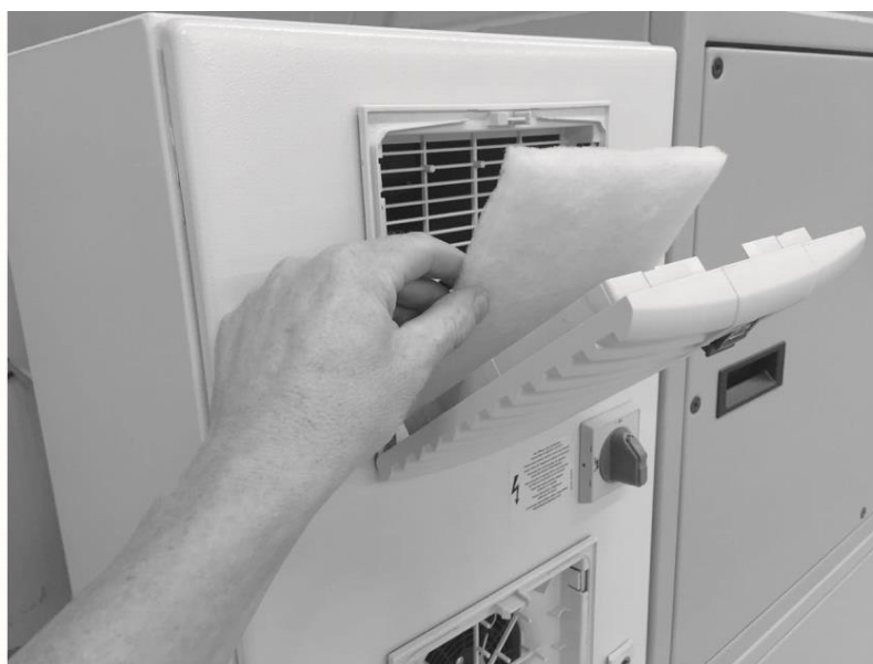
Рис. 153: Замена фильтра распределительного шкафа
