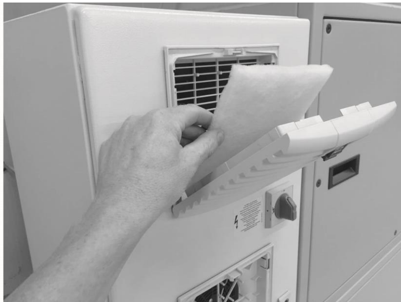
Fig. 210: Substituição do filtro no armário de distribuição
