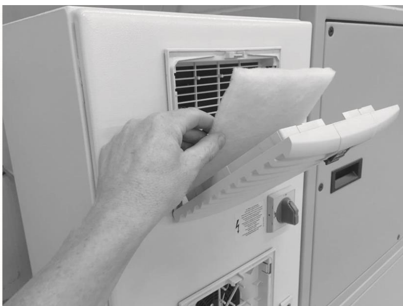
Fig. 267: Sostituzione filtro e quadro elettrico
