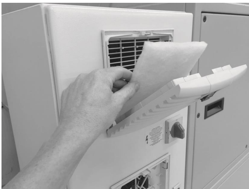
Fig. 39 : remplacement du filtre armoire de commande
