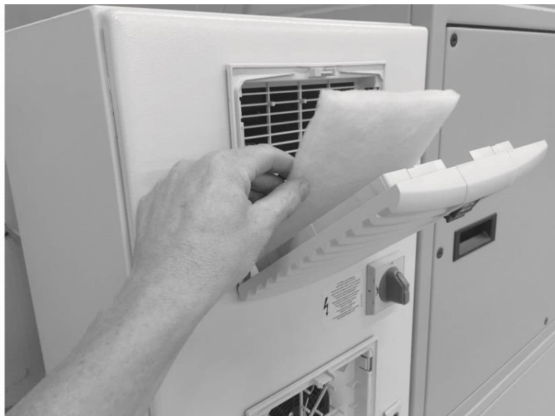
Abb. 57: Filterwechsel Schaltschrank
