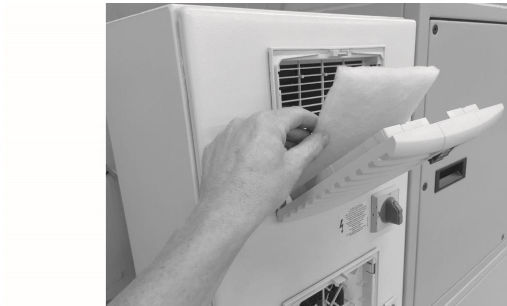
Obr. 57: Výměna filtrů skříňového rozvaděče
