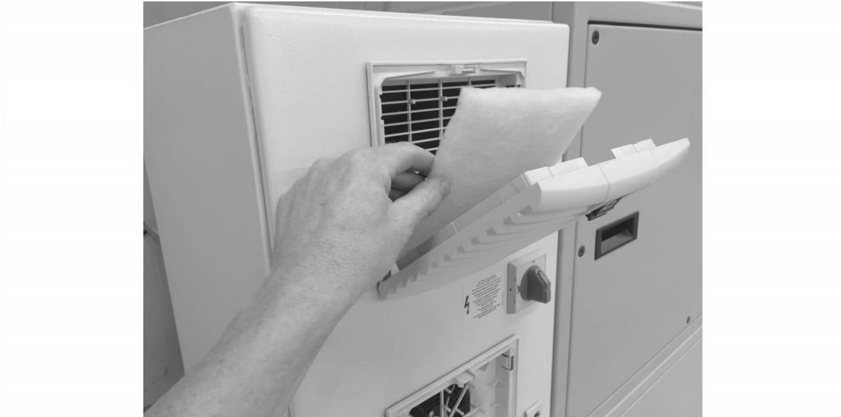
*Fig. 57 : remplacement du filtre armoire de commande*
