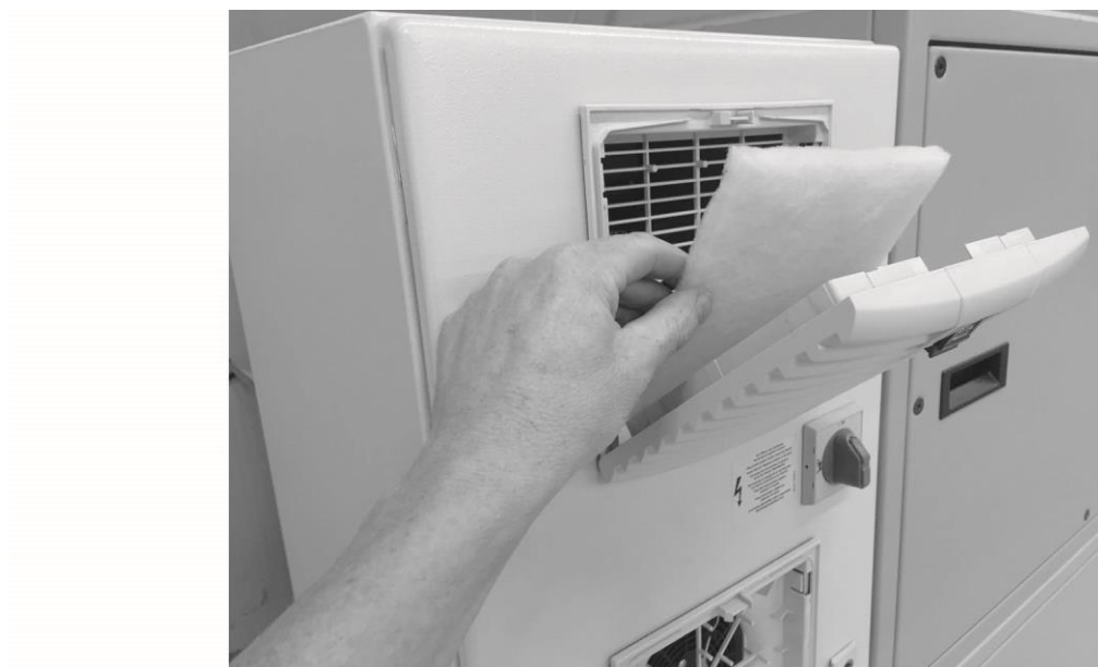
Fig. 39 : remplacement du filtre armoire de commande
