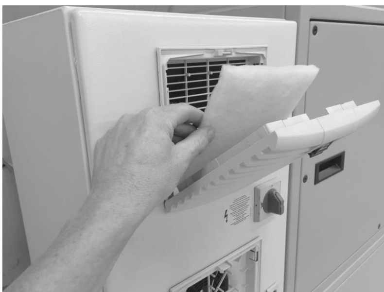
Fig. 346: Sostituzione filtro e quadro elettrico
