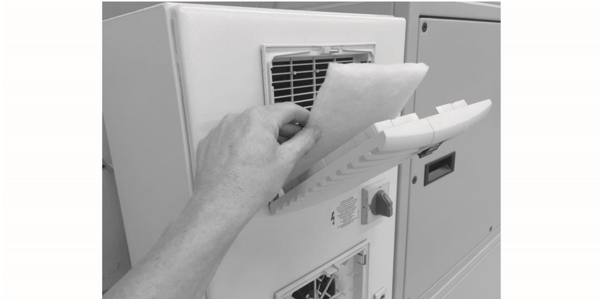
Afb. 130: Filtervervangning schakelkast
