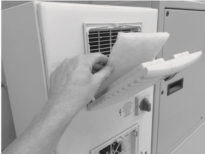
Fig. 274: Substituição do filtro no armário de distribuição
