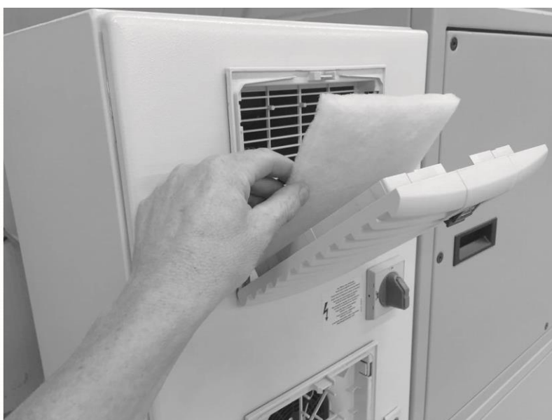
Fig. 202: Cambio del filtro del armario de distribución
