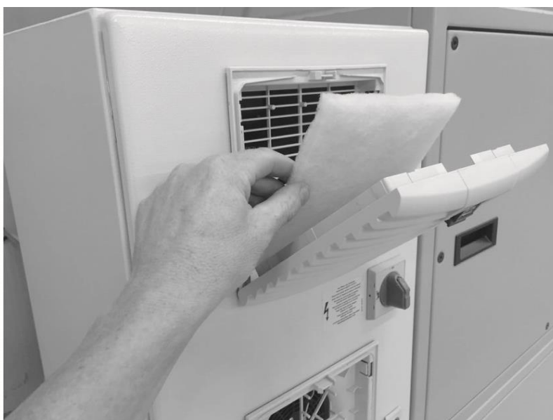
Рис. 202: Замена фильтра распределительного шкафа
