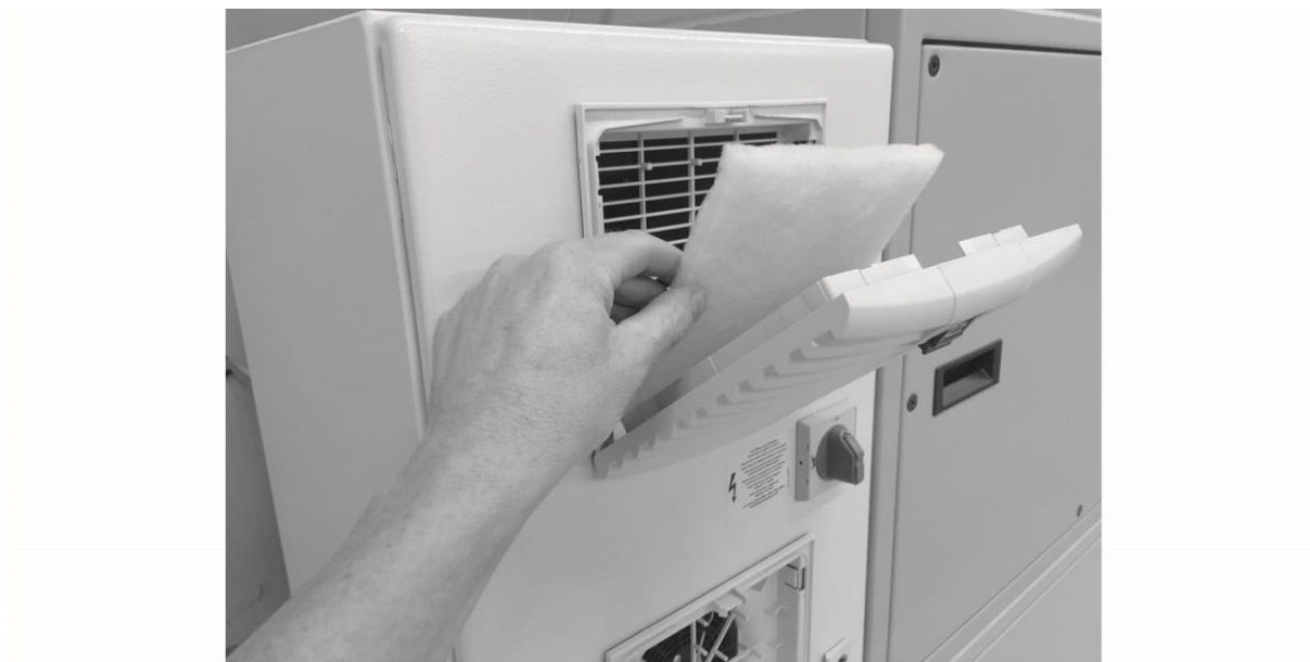
Obr. 58: Výměna filtrů skříňového rozvaděče
