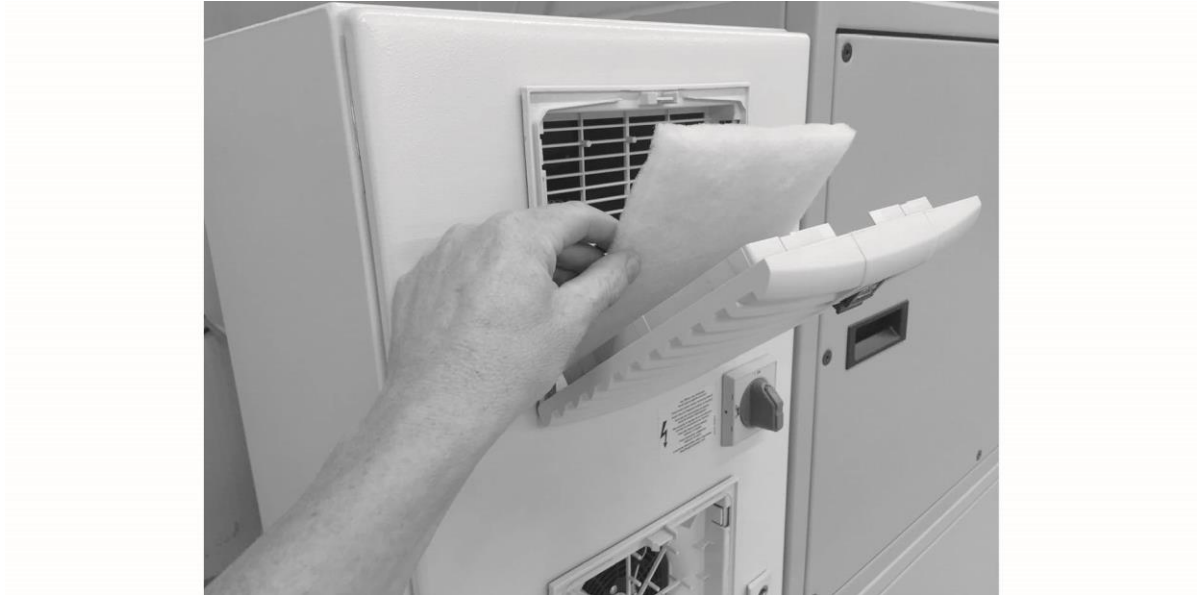
Afb. 99: Filtervervangning schakelkast
