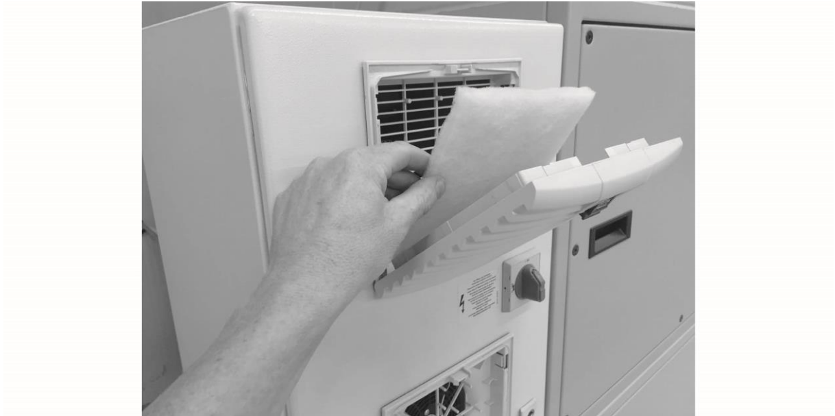
Fig. 39 : remplacement du filtre armoire de commande
