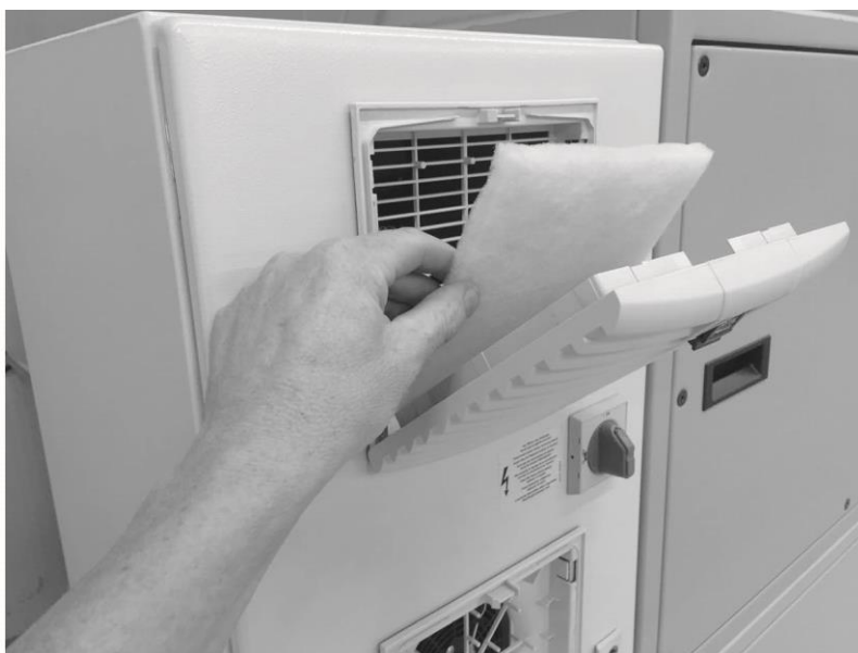
Fig. 279: Sostituzione filtro e quadro elettrico
