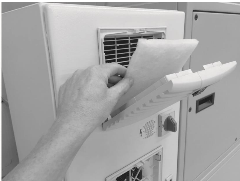
Fig. 159: Cambio del filtro del armario de distribución
