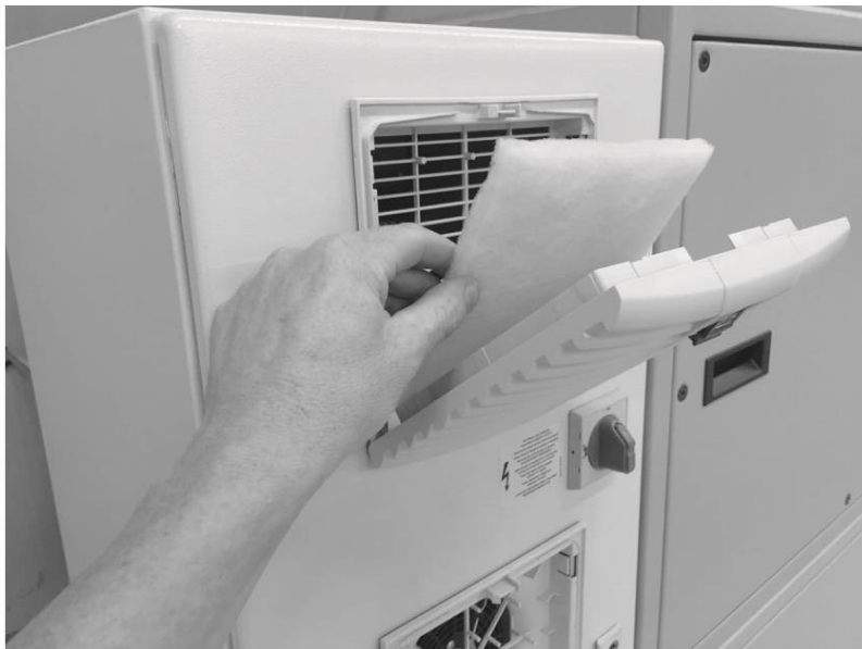
Рис. 159: Замена фильтра распределительного шкафа
