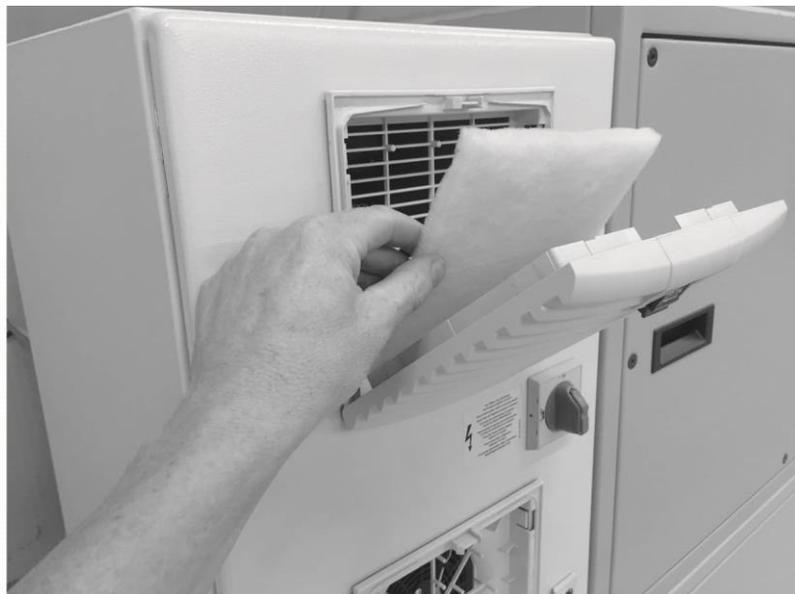
*Abb. 39: Filterwechsel Schaltschrank*
